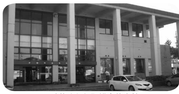
▲改修された町総合体育館
