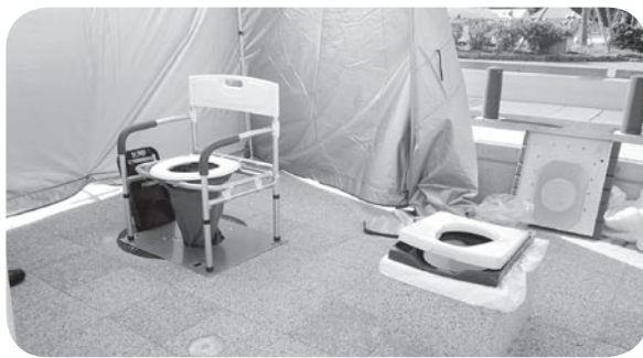
▲設置されたマンホールトイレ (あがた公園)
