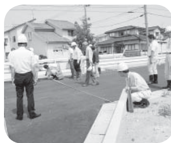
▲道路幅を確認
