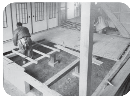
◀リフォームされる住宅
