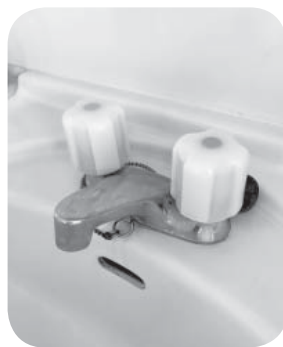
▲改修前の手洗い水栓
