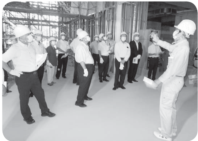
▲内部工事をしっかりチェック
