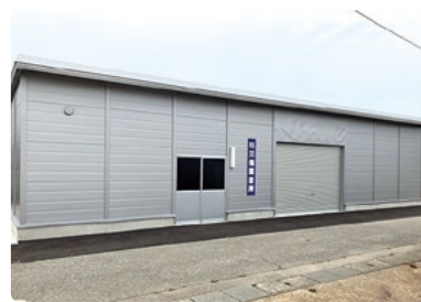
地域防災力の向上「井上地区防災備蓄施設」整備
