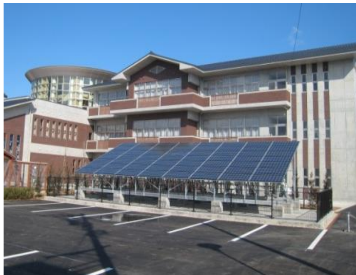
【自然再生エネルギーを活用した設備・津幡小学校】
