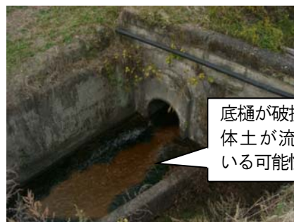
写真11：底樋出口（堤体下流）
