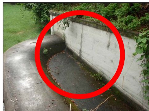
写真9：洪水吐流入部
