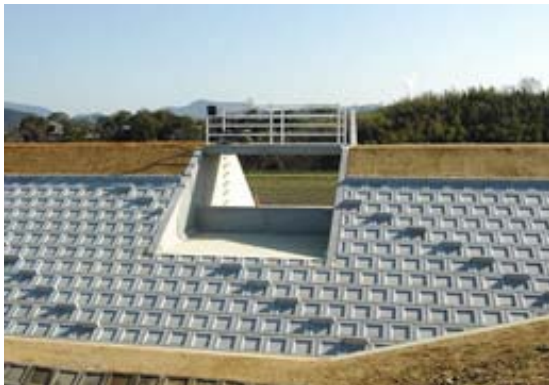
写真1：洪水吐 (香川県HPより)
