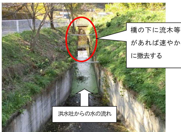
写真8：洪水吐下流水路の例
