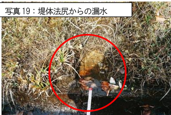
図 12：小段承水路の堆砂、堤体下流法面からの水の浸み出し
