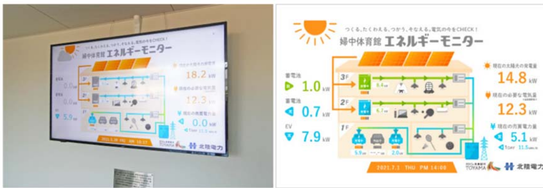
婦中体育館に設置されたデジタルサイネージ ※
