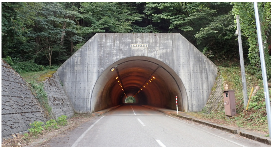
写真1 下中トンネル全景
