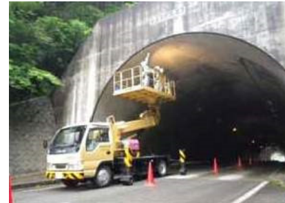
写真2 トンネル点検状況
